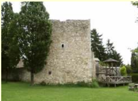
Der Reckturm in Laa/Thaya
